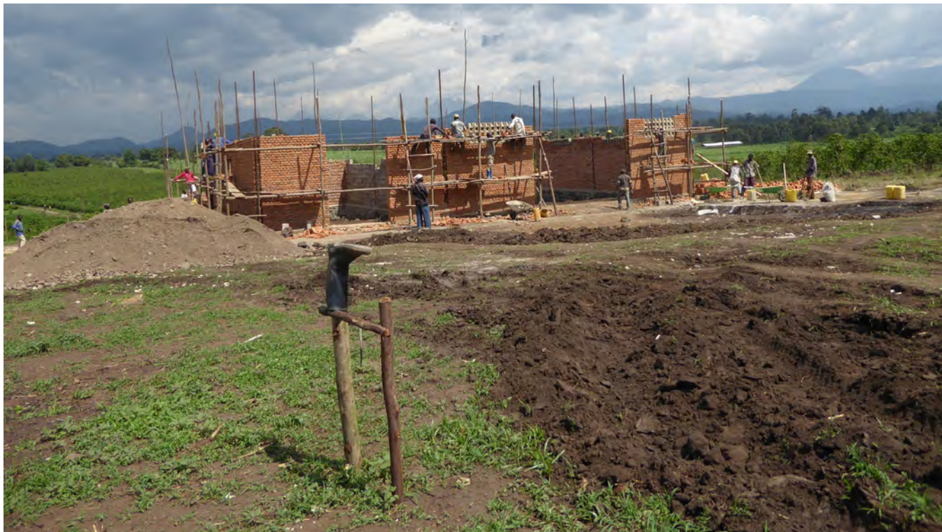
Construcción molino de Rubare (Rep. Dem. del Congo).
