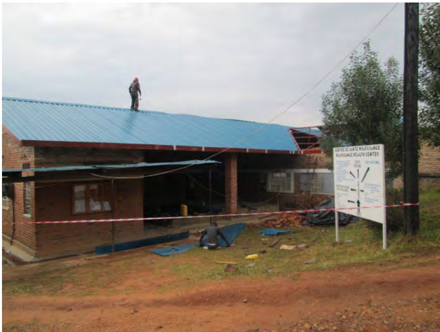
Cambio de tejados del Centro Nutricional de Nyarusange (Ruanda).
